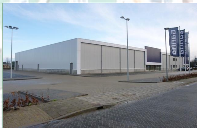
Nieuwbouw bouwmarkt (Apeldoorn)
